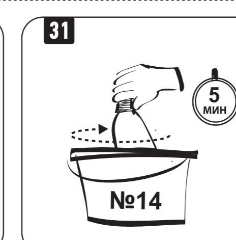
Перемешивайте содержимое ведра №14 вручную шпателем 5 мин. Нельзя использовать для перемешивания дрель с мешалкой.
